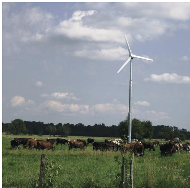
Äsja püstitatud 10 kW väiketuulik Saaremaal Kaarma vallas Jurna Turismitalus. Paigaldaja: Bakeri OÜ
